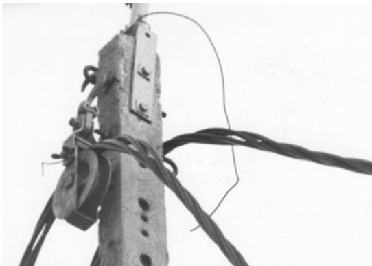
Rok 1975/1976 Pierwsze linie z przewodami izolowanymi
