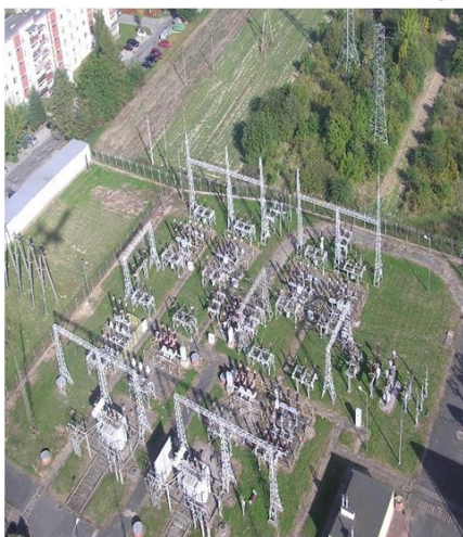
WIDOK ROZDZIELNI 110KV ISTNIEJĄCEJ ORAZ NOWEJ O BUDOWIE ZAMKNIĘTEJ (GIS), DWUSYSTEMOWEJ PRZEDSTAWIONEJ NA POWYŻSZYM SCHEMACIE.
