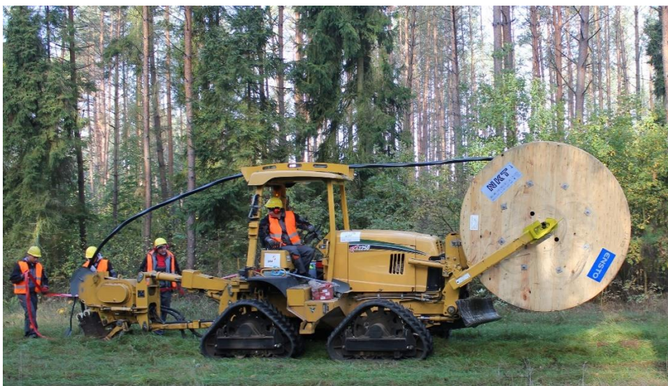
Rys. 7. Pierwsza instalacja metodą płuzenia w OSD – Energa Operator. Pługoukładacz wibracyjny, układający kabel trzyżyłowy AXAL-TT-PRO
