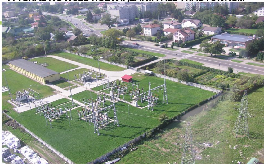
STACJA W UKŁADZIE H5 Z WYŁĄCZNIKAMI SF 6 ZMODERNIZOWANA
