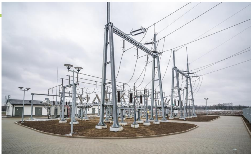
STACJA W UKŁADZIE H5 Z POLAMI 110 KV W WYKONANIU MODUŁOWYM
