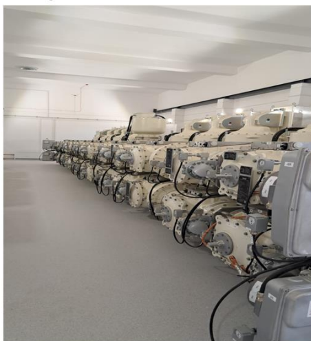
WIDOK ROZDZIELNI 110KV ISTNIEJĄCEJ ORAZ NOWEJ O BUDOWIE ZAMKNIĘTEJ (GIS), DWUSYSTEMOWEJ PRZEDSTAWIONEJ NA POWYŻSZYM SCHEMACIE.
