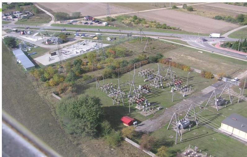
STACJA W UKŁADZIE H5 Z WYŁĄCZNIKAMI GAZOWYMI I MAŁOOLEJOWYMI
