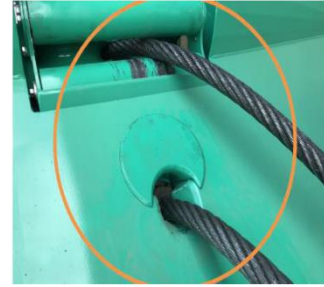
wyprowadzenie liny podwójnej z wciągarki ciągnika gąsienicowego
