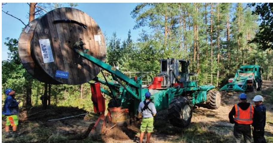
Rys. 8. Tauron Dystrybucja układanie kabla AXAL-TT-PRO metodą pługa ciągnionego
