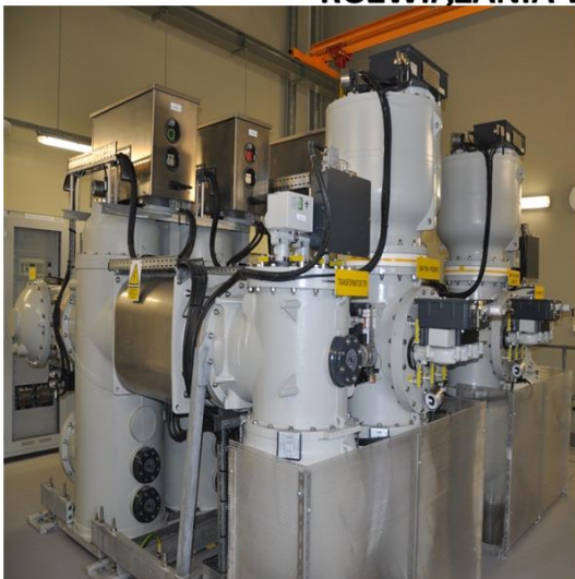
ROZDZIELNIA 110KV O BUDOWIE ZAMKNIĘTEJ (GIS), UKŁAD H5. W TEJ STACJI CAŁOŚĆ URZĄDZEŃ ZNAJDUJE SIĘ W JEDNYM BUDYNKU
