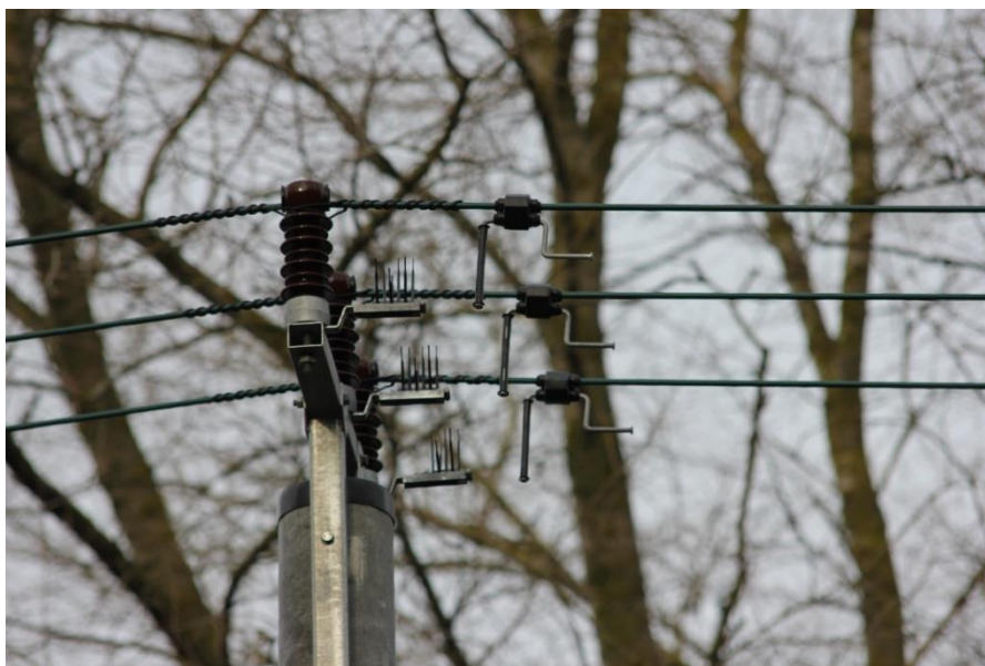
Rys. 3. System PAS z przewodami BLL-T (CCST AAAC 24 kV W) w trójwarstwowej osłonie izolacyjnej
