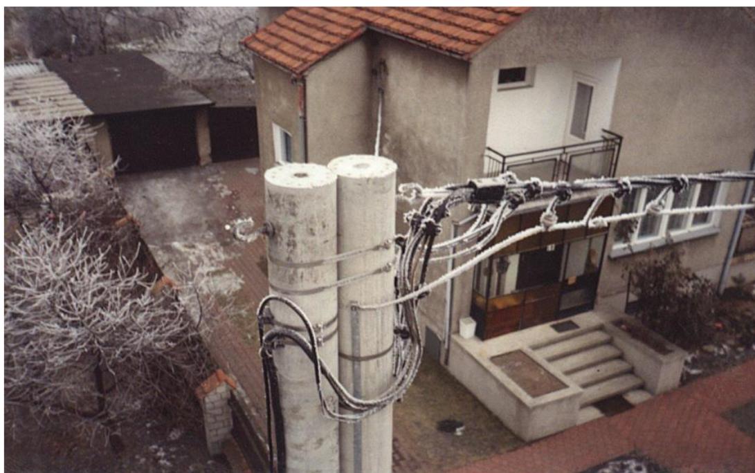
Badanie oddziaływania warunków atmosferycznych na przewody i na konstrukcje wsporcze
